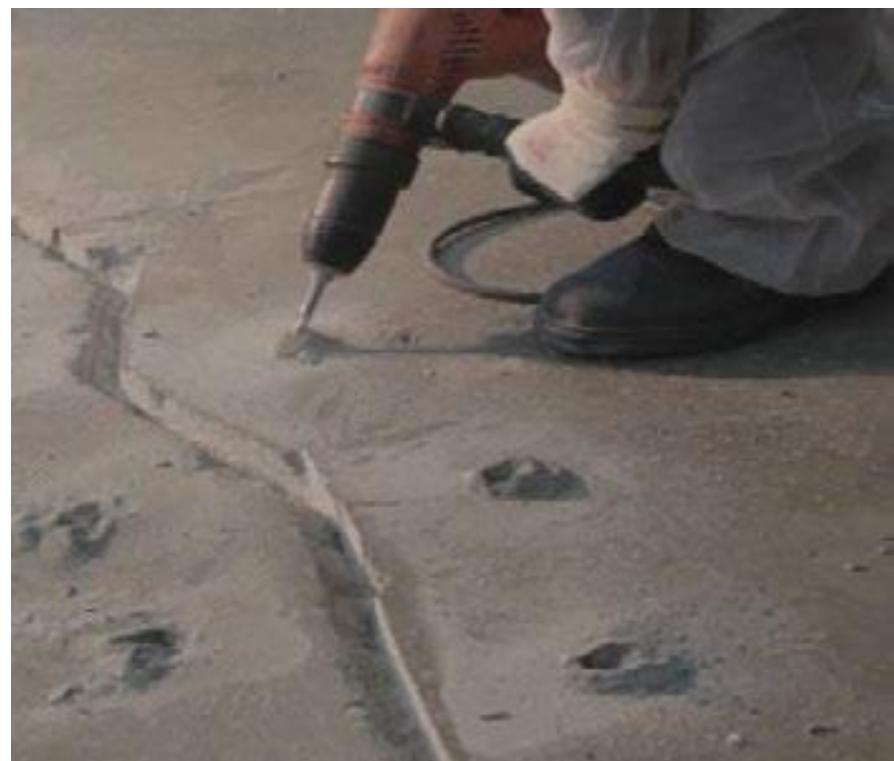
Рисунок 3 – Бурение отверстий для установки инъекторов
