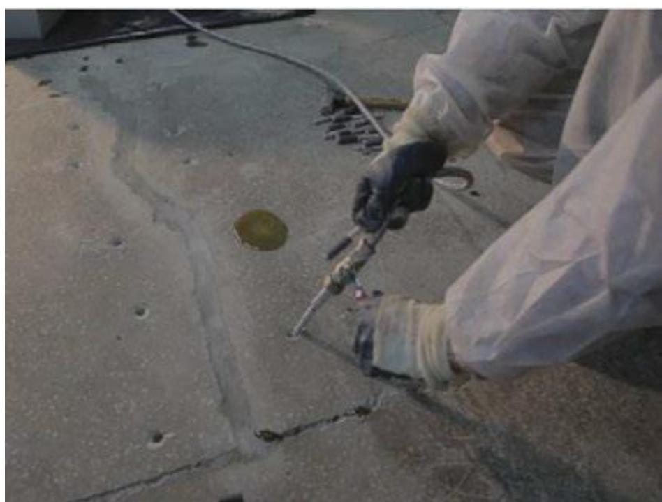
Рисунок 4 – Выполнение инъекционных работ
