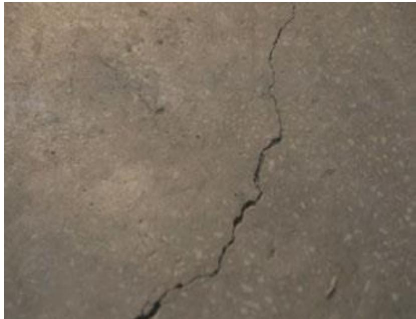
Рисунок 1 – Подвижная трещина. Общий вид
